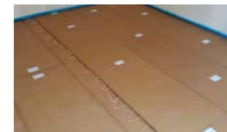
Modulbau - PhoneStar mehrlagig verklebt verlegt
