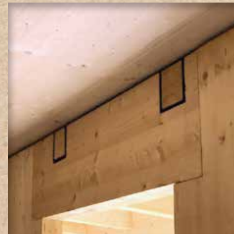
PhoneStrip kann auch als Schattenfuge eingesetzt werden
