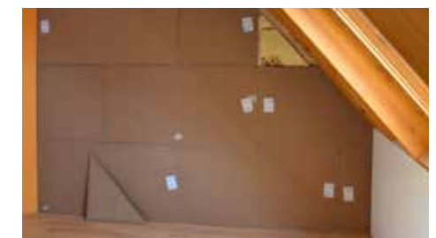
Wanddämmung PhoneStar ST
