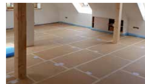
Dachbodenausbau PhoneStar einlagig verlegt
