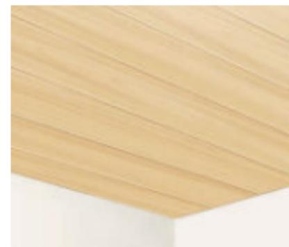
05 Für den Deckenabschluss die Vollholzprofile so ablängen, dass 10-15 mm Abstand zur Wand bleiben. Der Übergang zur Wand kann mit einer Abschlussleiste gestaltet werden.
