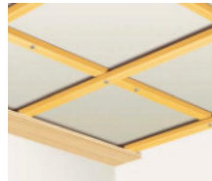
03 Das erste Vollholzprofil wird mit dünnen Stahlstiften auf der Unterkonstruktion befestigt (Feder zur Wandseite). Auf genaue Ausrichtung achten! Eine Schattenfuge von 10-15 mm ist zu berücksichtigen.
