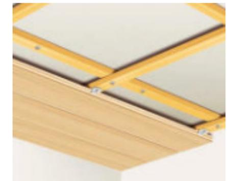
04 Das folgende Profilholz mit der Federin die Nut des ersten schieben. Gleichmäßiges Anklopfen (mit Brettabschnitt) über die gesamte Länge sorgt für parallel verlaufende Profile. Das zweite und alle folgenden Vollholzprofile werden mit Profilklemmen an der Unterkonstruktion befestigt.
