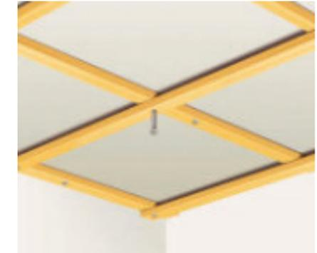
02 In Feuchträumen muss so hinterlüftet werden, dass die Luftbewegung in zwei Richtungen erfolgen kann. Dies wird durch eine Konterlattung erreicht, die rechtwinklig auf die erste Lattung geschraubt wird. Bitte beachten Sie, dass sich durch die Konterlattung die Verlegerichtung der Vollholzprofile ändert.
