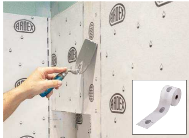
ARDEX SK 12 TRICOM Dichtband verkleben
