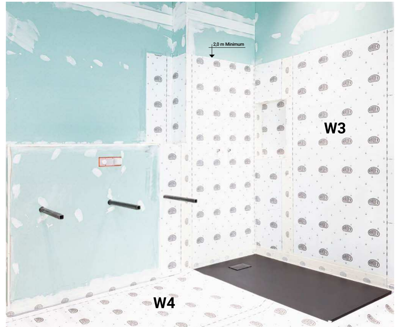
Vollständig ausgeführte Abdichtung: Duschbereich W3, Boden W4 Ausführung lt. Ö-Norm (siehe Seite 86)
