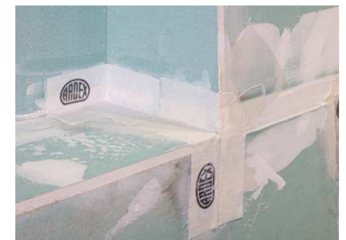
ARDEX SK 270 TRICOM Außenecke mit ARDEX AF 181 W verkleben
