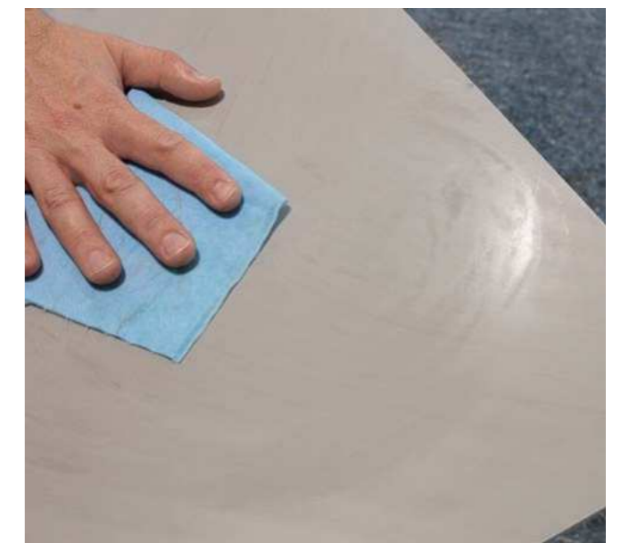
Plattenrückseite reinigen
