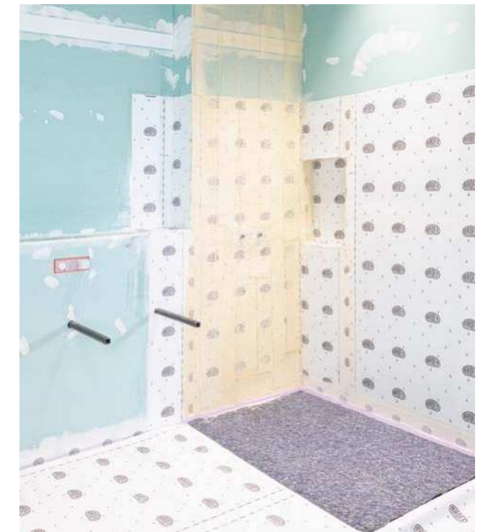
Der Klebstoff sollte kurz ablüften
