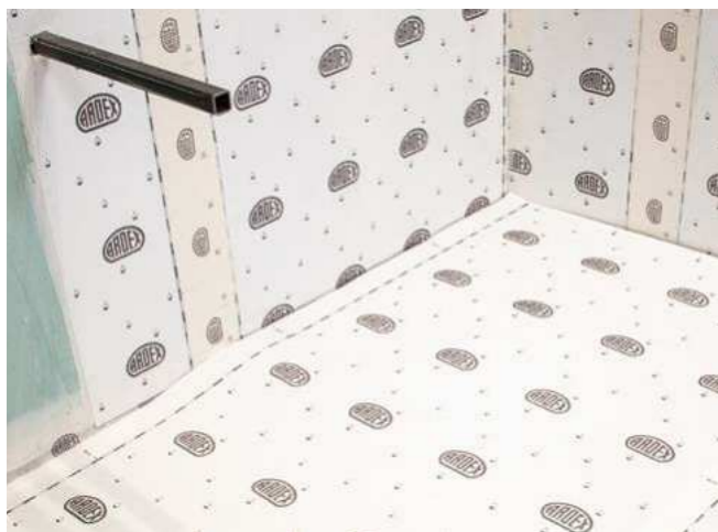
ARDEX SK 100 W TRICOM Dichtbahn am Boden verkleben
