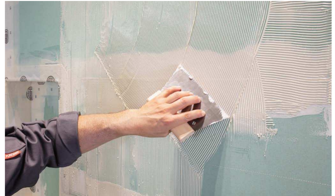
Kleber ARDEX AF 181 W mit Zahnpachtel (B2) auftragen und ca. 10 Minuten ablüften lassen
