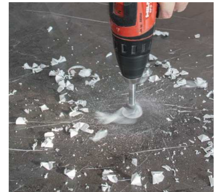
Aussparungen bohren bzw. schneiden
