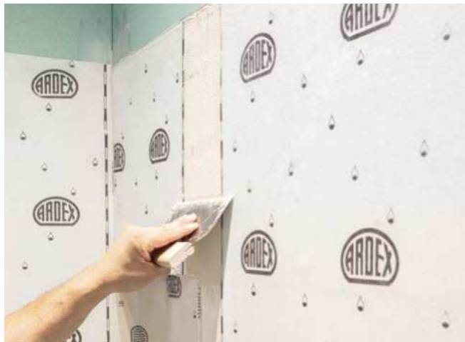
Kleber ARDEX AF 181 W im Stoßbereich aufbringen
