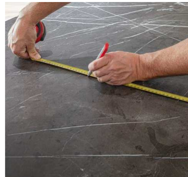
Zuschnittmaße auf Platten übertragen
