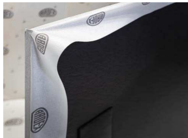
ARDEX SK 12 BT Wannendichtband an Duschtasse bzw. Badewanne anbringen
