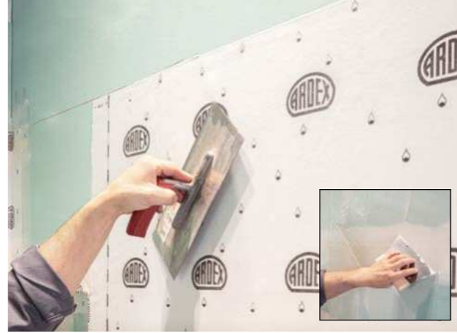
ARDEX SK 100 W TRICOM Dichtbahn verkleben
