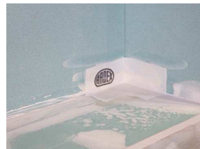
ARDEX SK 90 TRICOM Innenecke mit ARDEX AF 181 W verkleben
