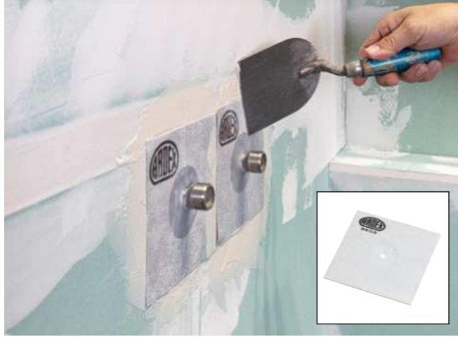
ARDEX SK-M TRICOM Dichtmanschette bei Rohrdurchführungen verkleben
