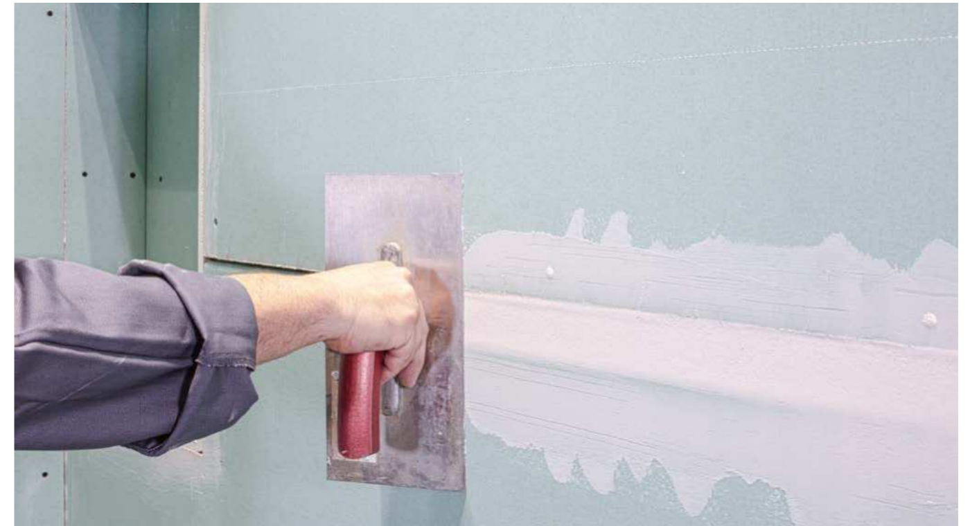
ARDEX R 1 Renovierungsspachtel aufbringen
