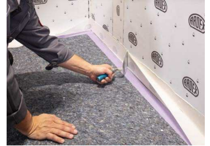
ARDEX SK 12 BT Wannendichtband an Wand verkleben
