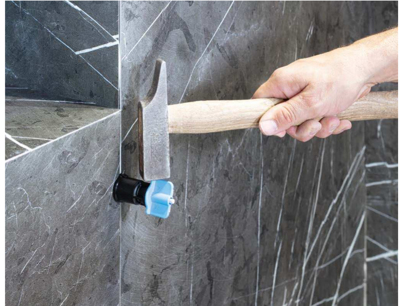
Zughaube mit Gewindelasche entfernen
